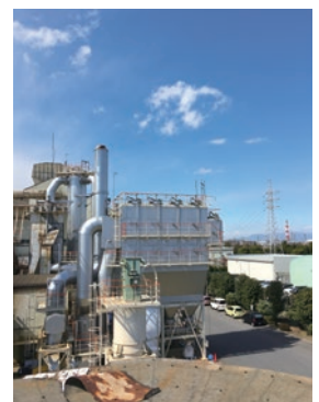
排ガス調質塔とバグフィルター
