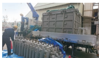
高濃度PCB廃棄物搬出の様子(埼玉工場)
