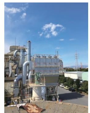
排ガス調質塔とバグフィルター
