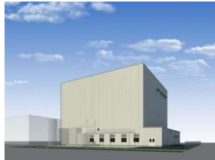
建設中の生産拠点の完成イメージ
