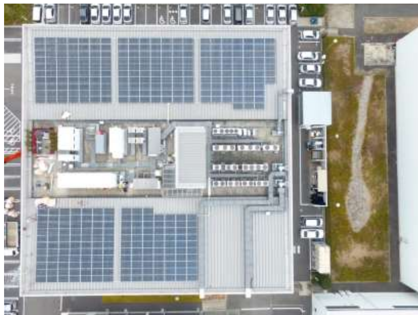
関西本社太陽光発電システム
