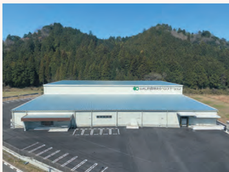
山村JR貨物きらベジステーション 本社工場
