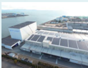
プラスチックカンパニー関西プラント (兵庫県)
