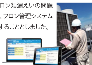
法定点検の様子とフロン管理システム
